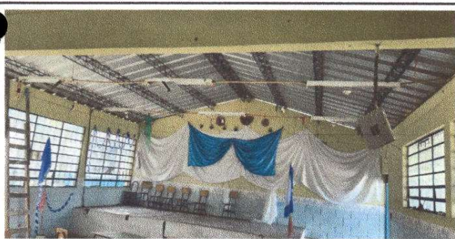
Foto 5: sustitución de cableado electrico
