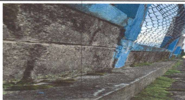
Foto 6: sustitucion de muro perimetral de block y maya hg
