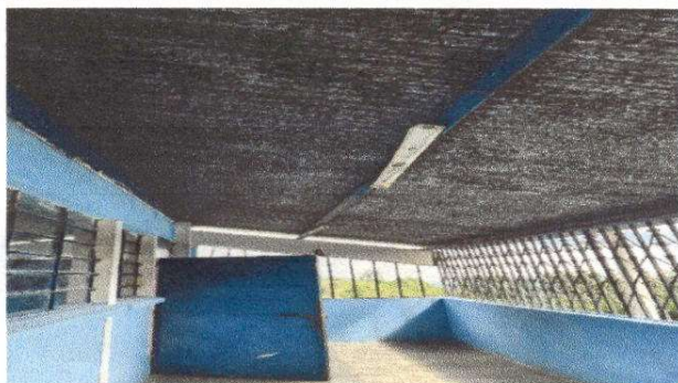
Foto 3: sustitucion de lampara por focos
