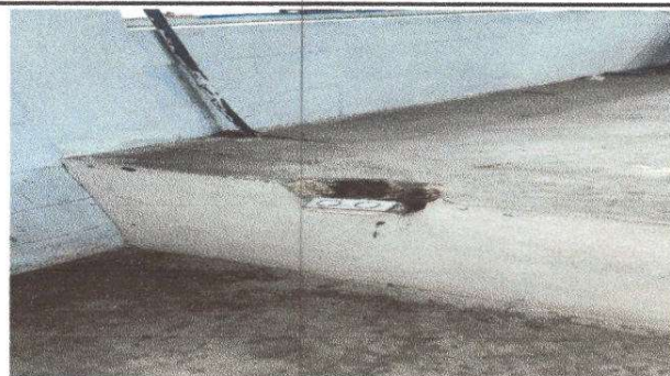
Foto 4: sustitución de tomacorrientes
